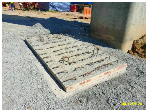
รูปที่ 2-9 การก่อสร้างโครงสร้างปรับการทรุดตัว
