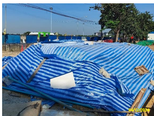
รูปที่ 2-26 การใช้ผ้าใบปิดคลุม กองดิน/กองเศษวัสดุ
