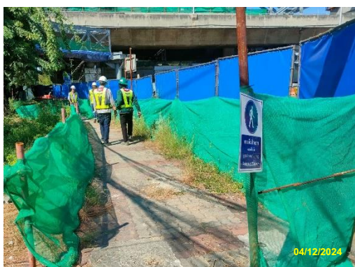
รูปที่ 2-35 การจัดทำทางเดินเท้าชั่วคราวบริเวณพื้นที่ก่อสร้าง
