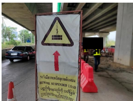
รูปที่ 2-51 การปิดเบี่ยงช่องทางจราจร ขณะยกชิ้นงานและการติดตั้งป้ายเตือนระวังวัสดุตกหล่นจากด้านบน
