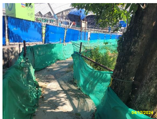
รูปที่ 2-35 การจัดทำทางเดินเท้าชั่วคราวบริเวณพื้นที่ก่อสร้าง
