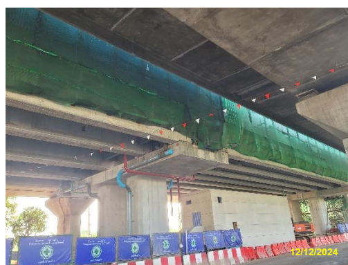
รูปที่ 2-11 การติดตั้งตาข่าย (Safety Net)
