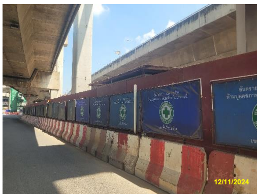
รูปที่ 2-18 การติดตั้งกำแพงคอนกรีต พร้อมรั้วผ้าใบทึบ ความสูง 2.0 เมตร
