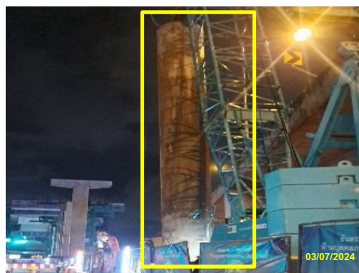
เสาเข็มเจาะหน้าตัดกลม (Circular Bored Pile)
