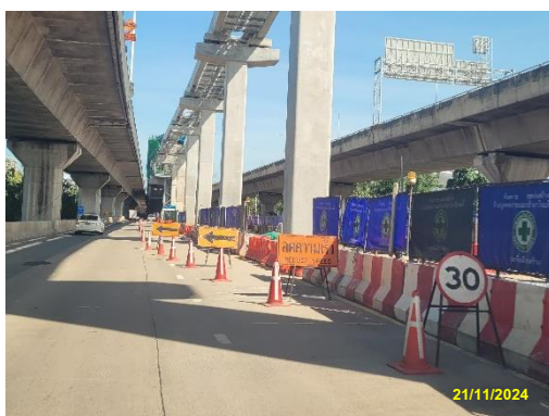
รูปที่ 2-51 การปิดเบี่ยงช่องทางจราจร ขณะยกชิ้นงานและการติดตั้งป้ายเตือนระวังวัสดุตกหล่นจากด้านบน
