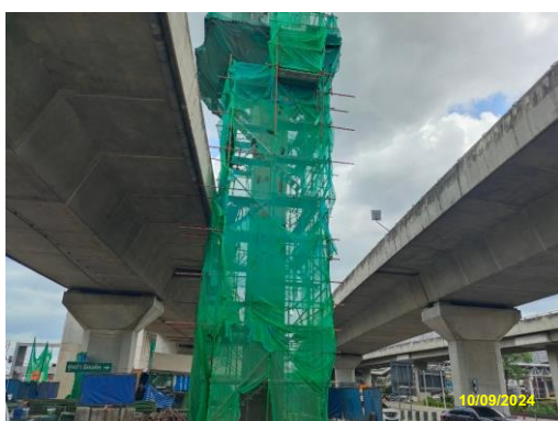
รูปที่ 2-11 การติดตั้งตาข่าย (Safety Net)
